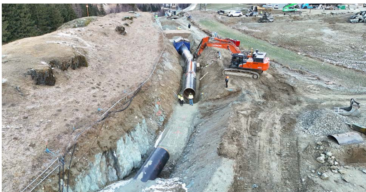
Einbau des letzten Rohres der Druckrohrleitung im Dezember 2025
