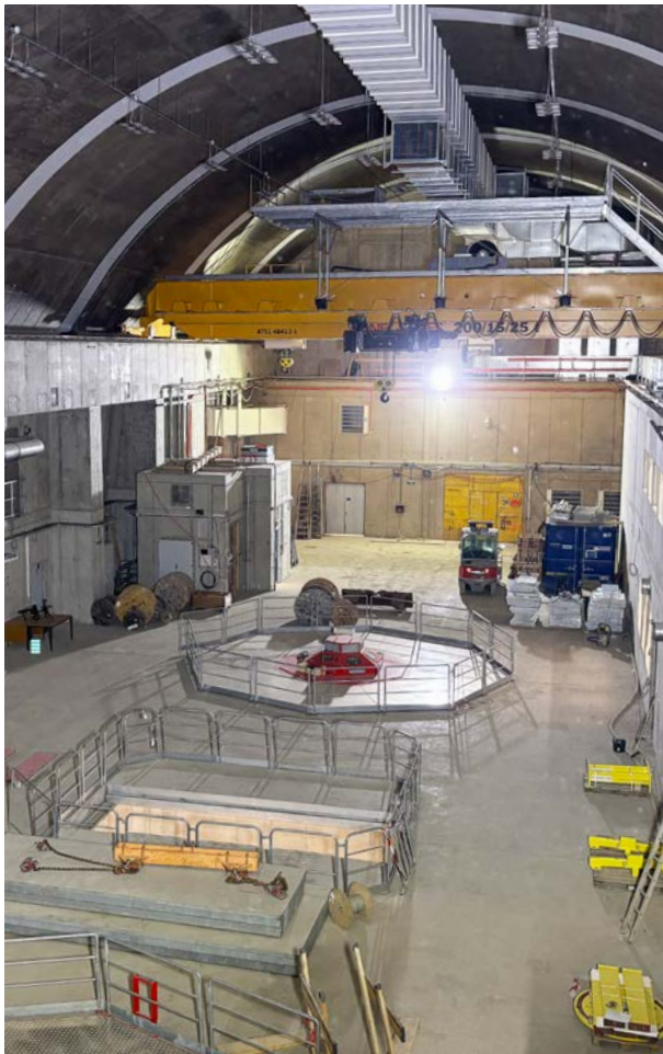
Die Betonarbeiten in der Kaverne wurden abgeschlossen.
