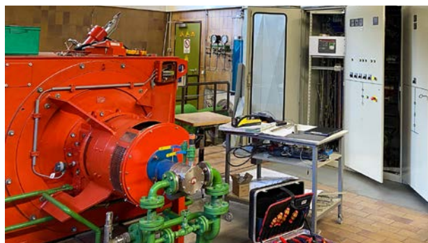
Der Generator des KW Urgbach wurde unter anderem mit Trockeneis gereinigt.
