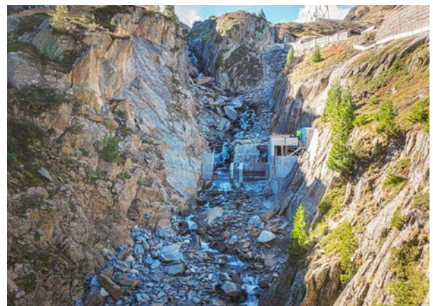
Die Wasserfassung Fernaubach im Stubaital
