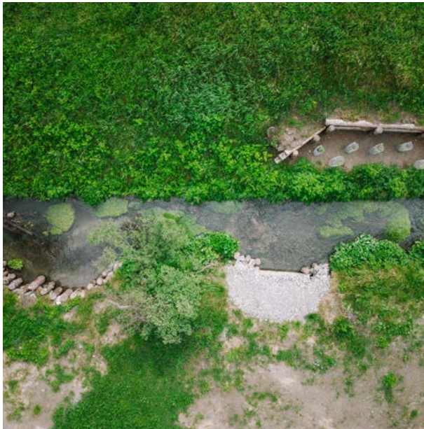
Strukturierungsmaßnahmen Bürgerau-Entwässerungsgraben bei Matrei
