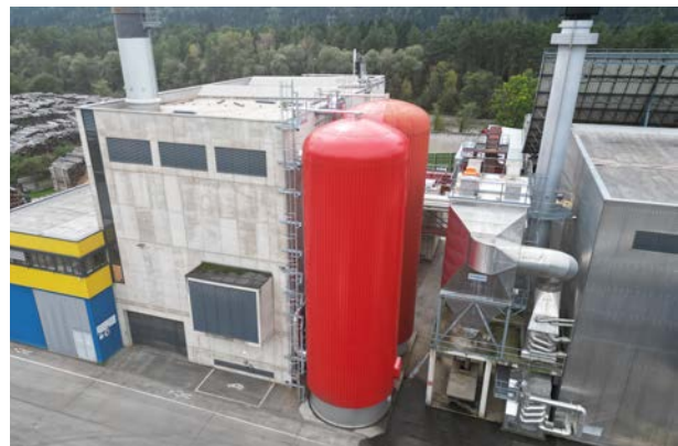
Der Pufferspeicher im Biomasseheizkraftwerk Lienz wird erweitert.
