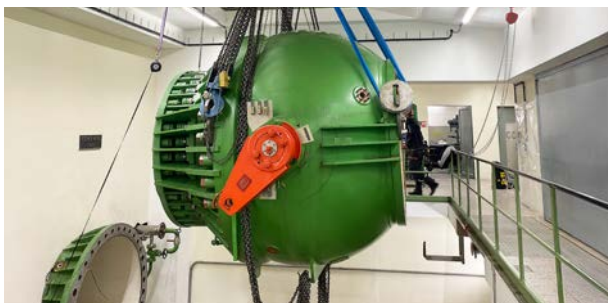
Ausheben des Kugelschiebers im Kraftwerk Imst.
