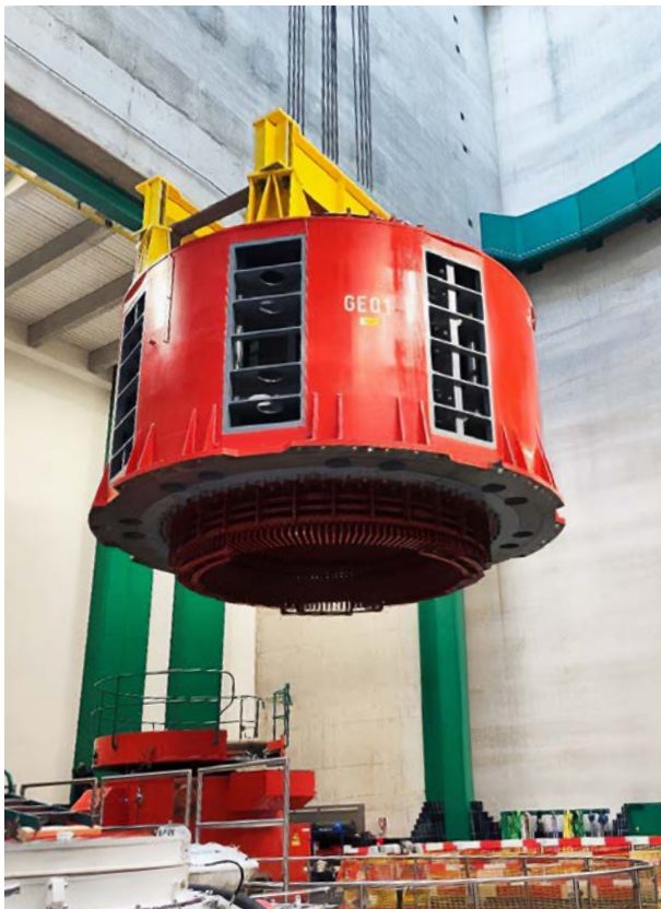
Der alte Stator wird ausgehoben ...
