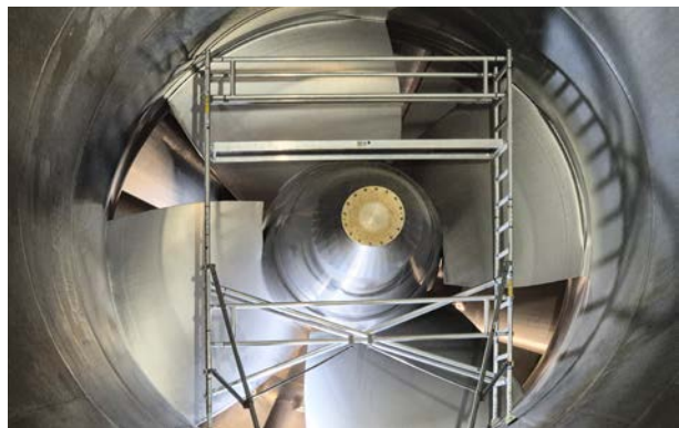
Im Zuge der Revision im KW Langkampfen wurden auch die Laufradflügel geprüft.
