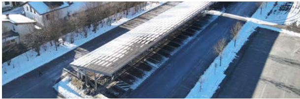
Die PV-Carportanlage Pertisau während der Inbetriebnahme-Phase im Dezember 2025
