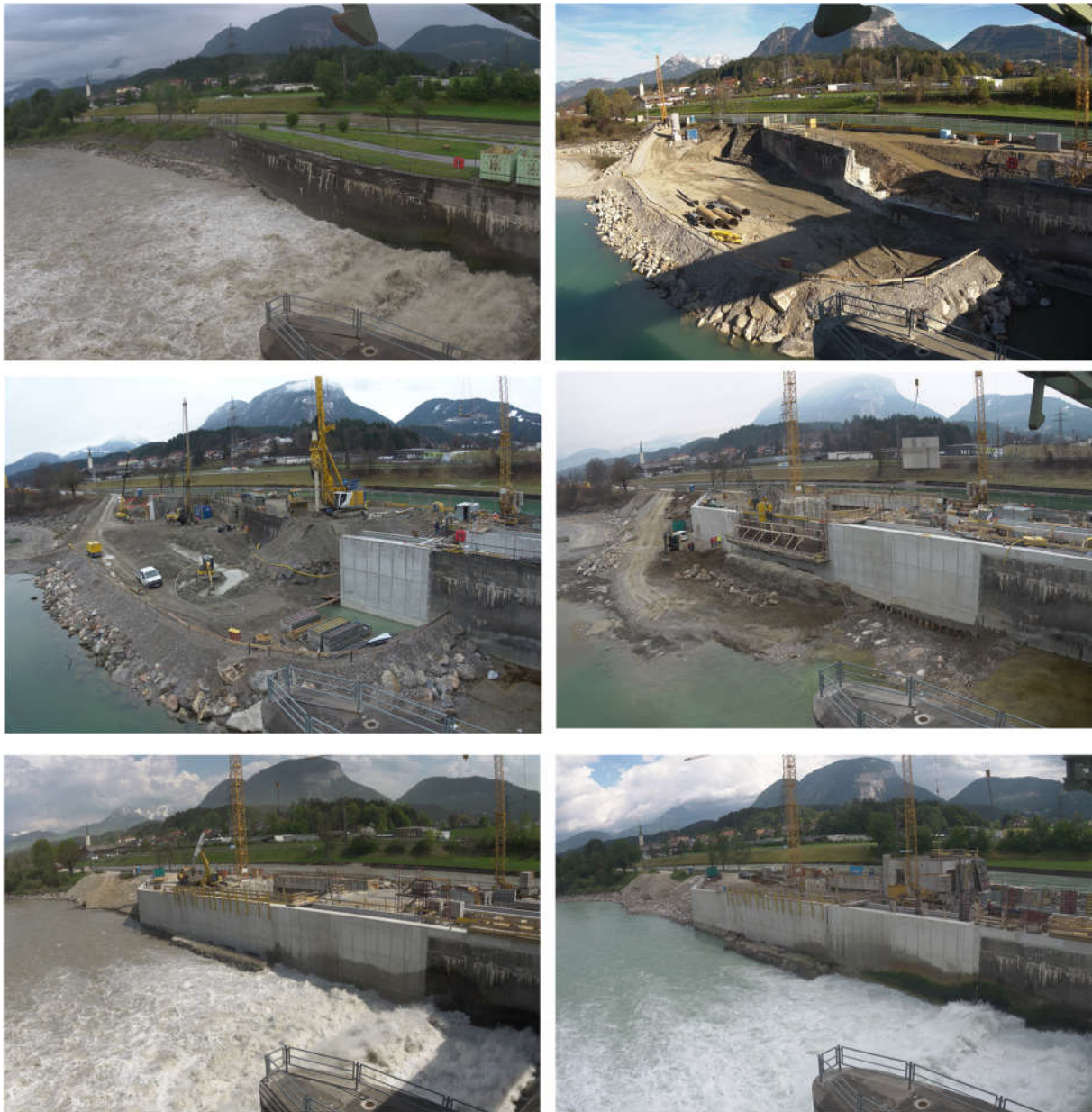
Abbildung 8: Errichtung Dotierkraftwerk und Fischwanderhilfe; Zeitraum August 2017 bis Juni 2018
