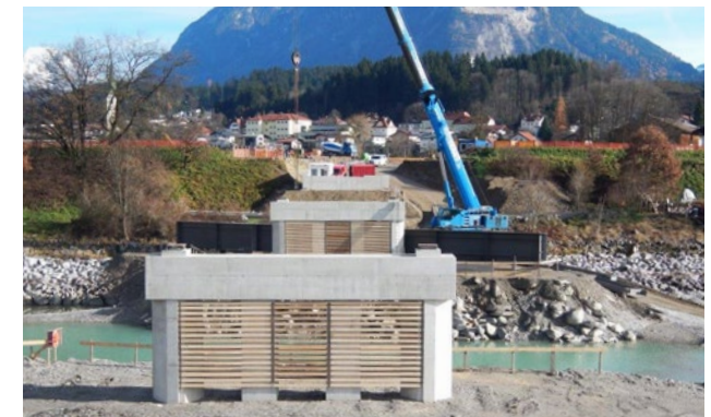
Errichtung der Baubehelfsbrücke
