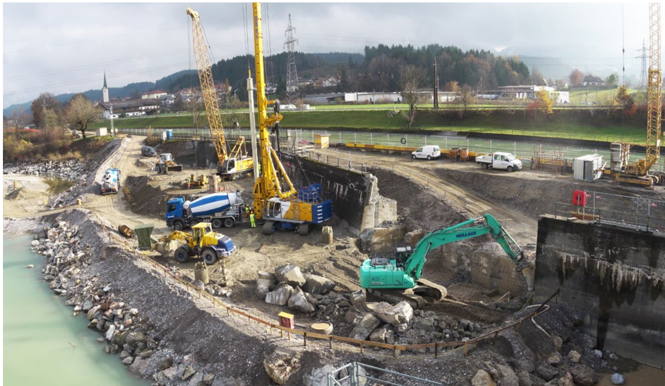
Bauarbeiten am Wehr
