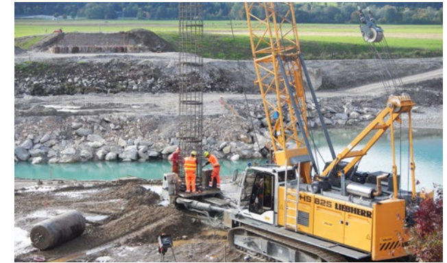
Herstellung Bohrpfähle für Baubehelfsbrücke
