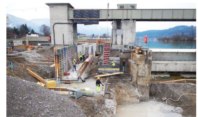
Herstellung Fischwanderhilfe
