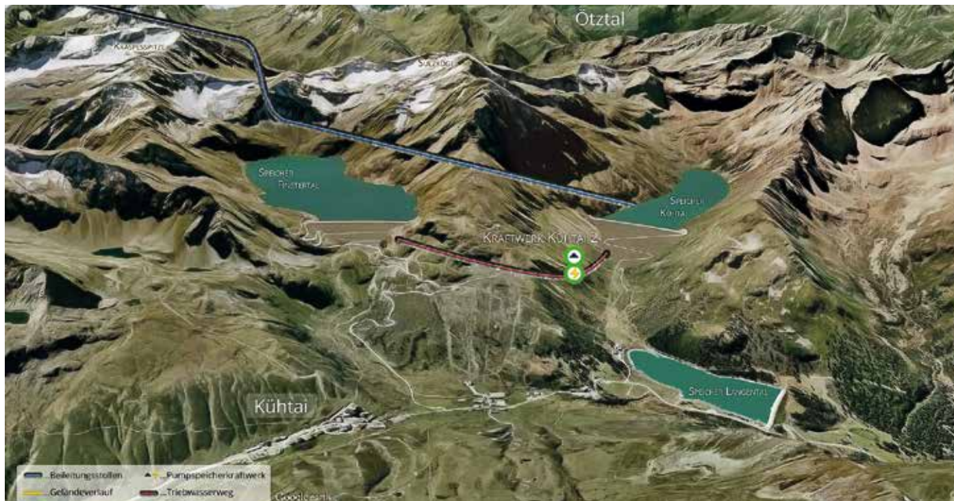
Die bestehenden Speicherseen Längental und Finstertal mit dem neuen Kraftwerk Kühtai 2, Speichersee Kühtai und Beileitungsstollen
