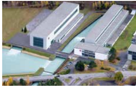
Ausbau Kraftwerk Kautertal
