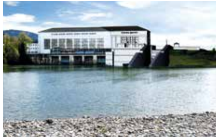
Erweiterung Kraftwerk Kirchbichl
