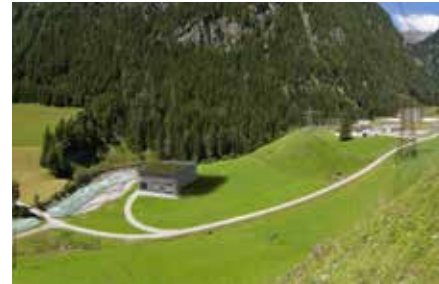
Kraftwerk Tauernbach - Gruben
