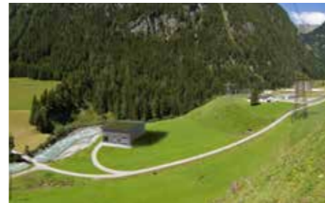
Kraftwerk Tauernbach - Gruben
