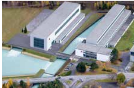
Ausbau Kraftwerk Kaunertal
