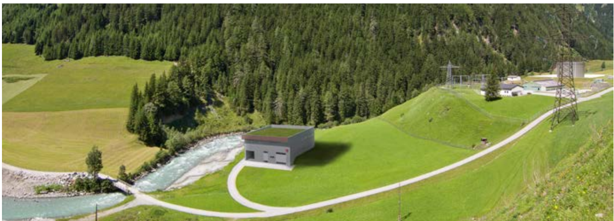
Das neue Krafthaus des Kraftwerks Tauernbach-Gruben ist direkt unterhalb der TAL-Pumpstation vorgesehen. Zwei Turbinen erzeugen nach der Fertigstellung durchschnittlich 85 Gigawattstunden Strom pro Jahr.
