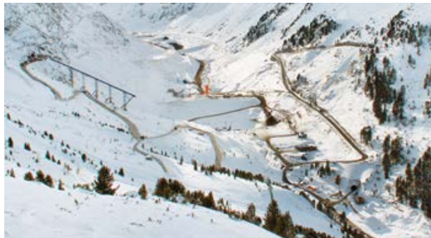
Die Baustelle des Erweiterungsprojekts Kühtai im Dezember 2021
