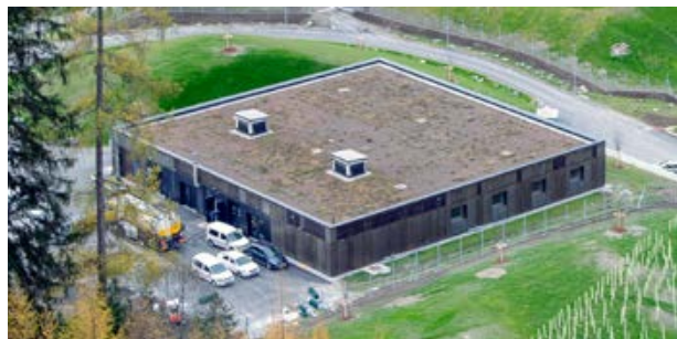
Das neue Krafthaus in Prutz/Ried
