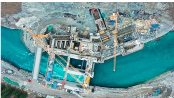
Übersicht über die Bauarbeiten in Ovella
