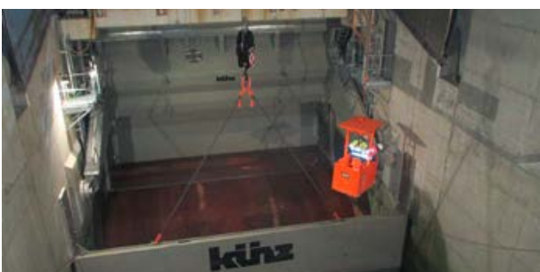
Montagearbeiten der Segmente an der Wehranlage
