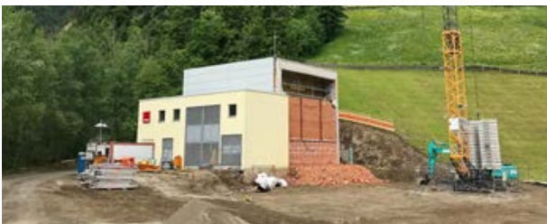
Das Krafthaus des KW Schwarzach in Huben in Osttirol während der Bauarbeiten.
