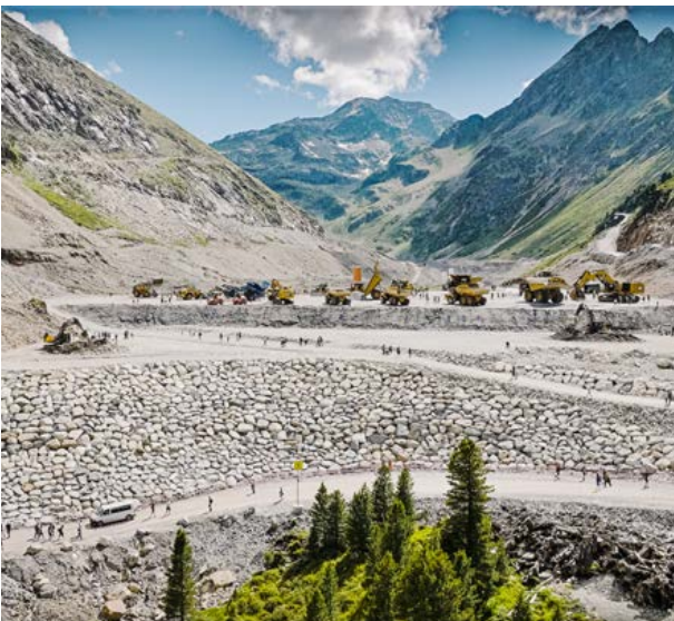
Tag der offenen Baustelle im Juni 2022: Rund 6.000 BesucherInnen schauten auf der Baustelle im Kümtai vorbei.
