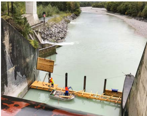
Unterwasserseitige Abdämmung des Wehrs Runserau
