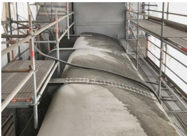
Einrüstung und Einhausung
