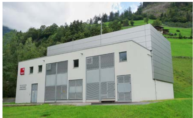
Das fertiggestellte Krafthaus des KW Schwarzach in Huben in Osttirol.
