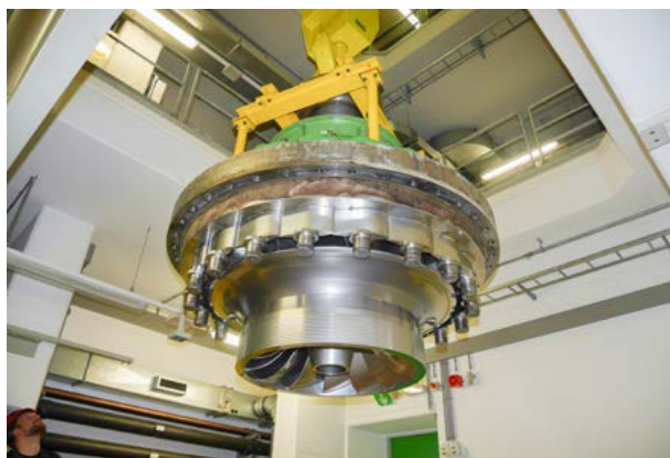
Ausheben des Turbinen-Kompaktteils im Kraftwerk Amlach
