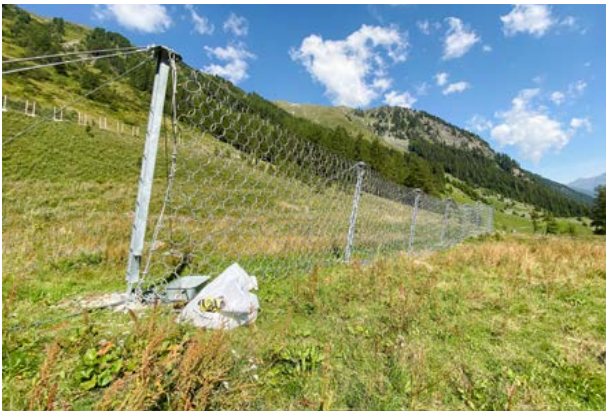
Die installierten Steinschlagschutznetze sichern die Portalzugänge.
