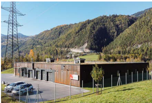
Das fertiggestellte GKI-Krafthaus in Prutz.
