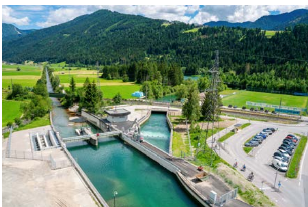
Die generalsanierte Wehranlage Tassenbach.
