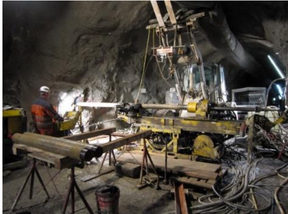
Erkundungsbohrung im Sondierstollen Klasgarten bei den Planungen
