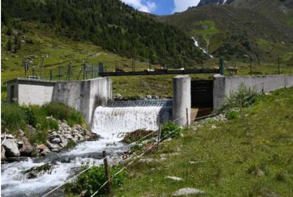
Wasserfassung Horlachbach bei Überwasser
