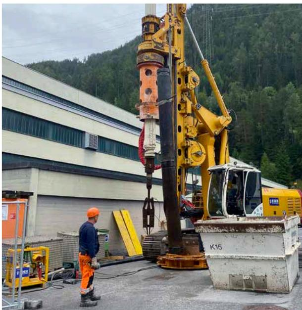
Die alten Filterrohre wurden entfernt und durch neue Edelstahl-Rohre ersetzt.
