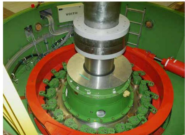
Der Kompaktteil der Turbine wurde herausgehoben, komplett saniert und wieder eingebaut.
