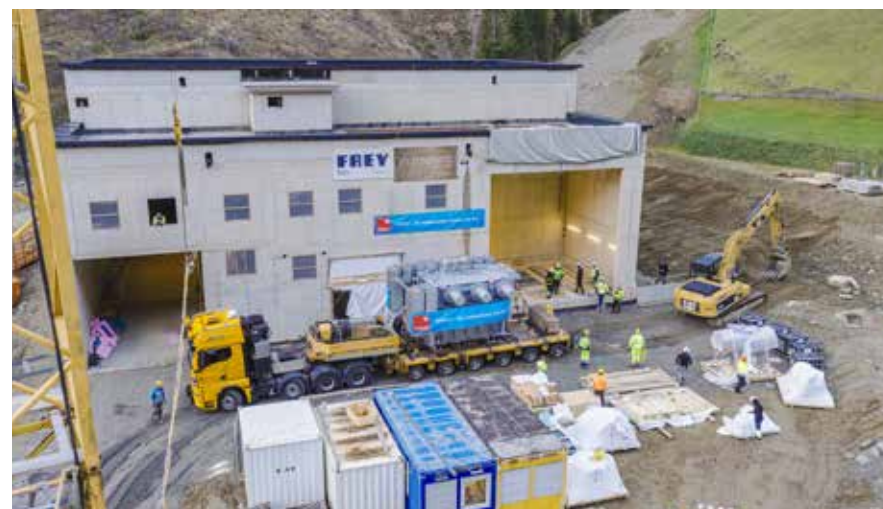
Anlieferung Maschinentransformator ins Krafthaus.
