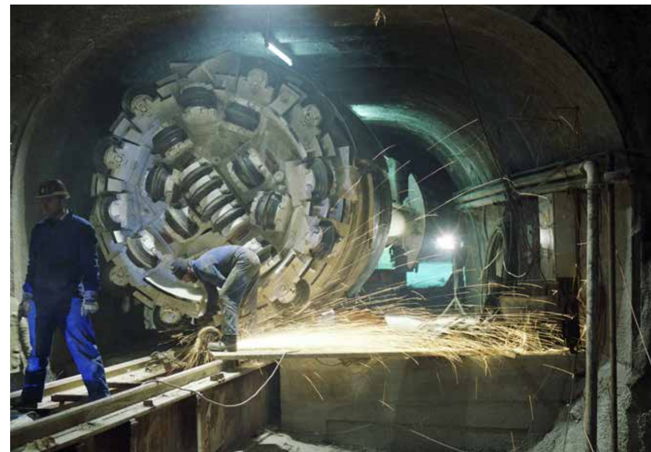
Bauarbeiten am Kraftwerk Heinfels 1992.
