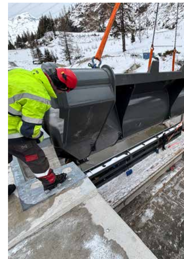
Präzisionsarbeit: das Einheben der Wehrklappe im Februar 2026.
