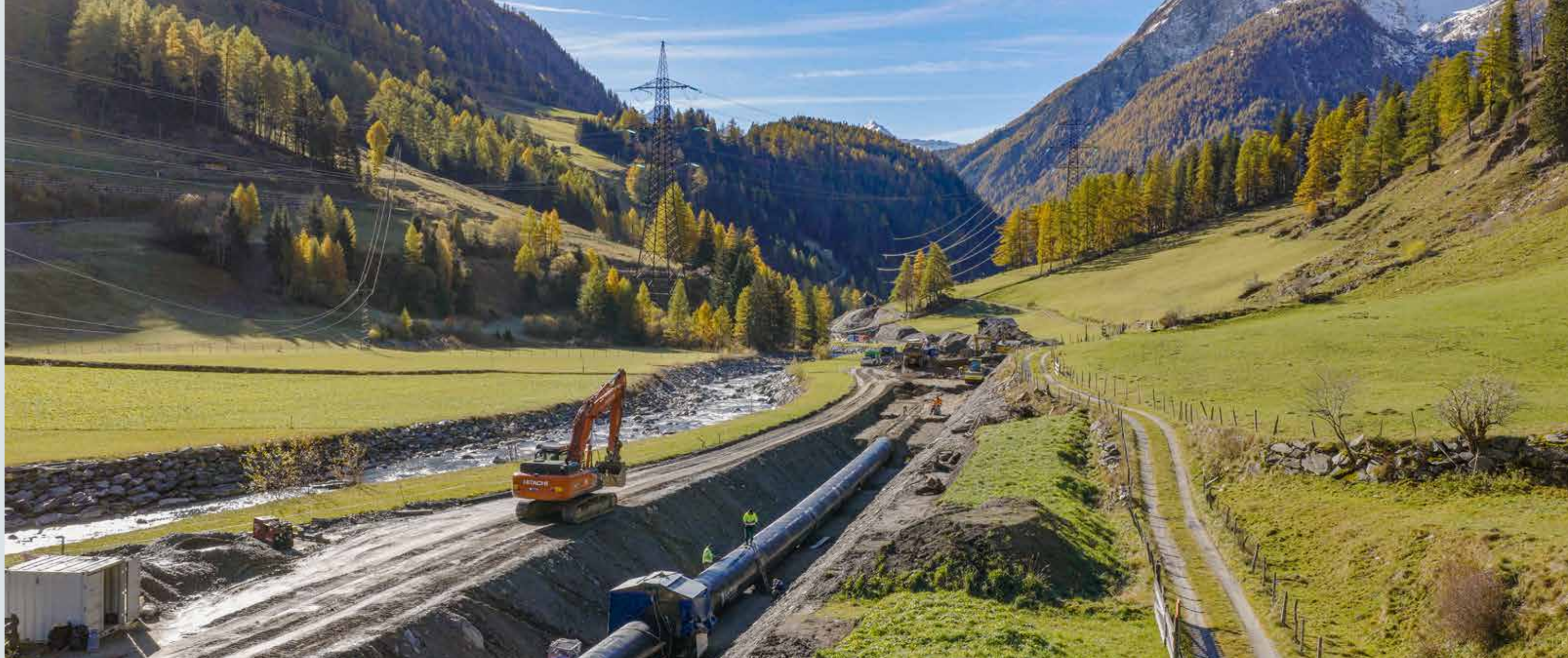
Bauarbeiten an der Druckrohrleitung entlang des Tauernbaches.
