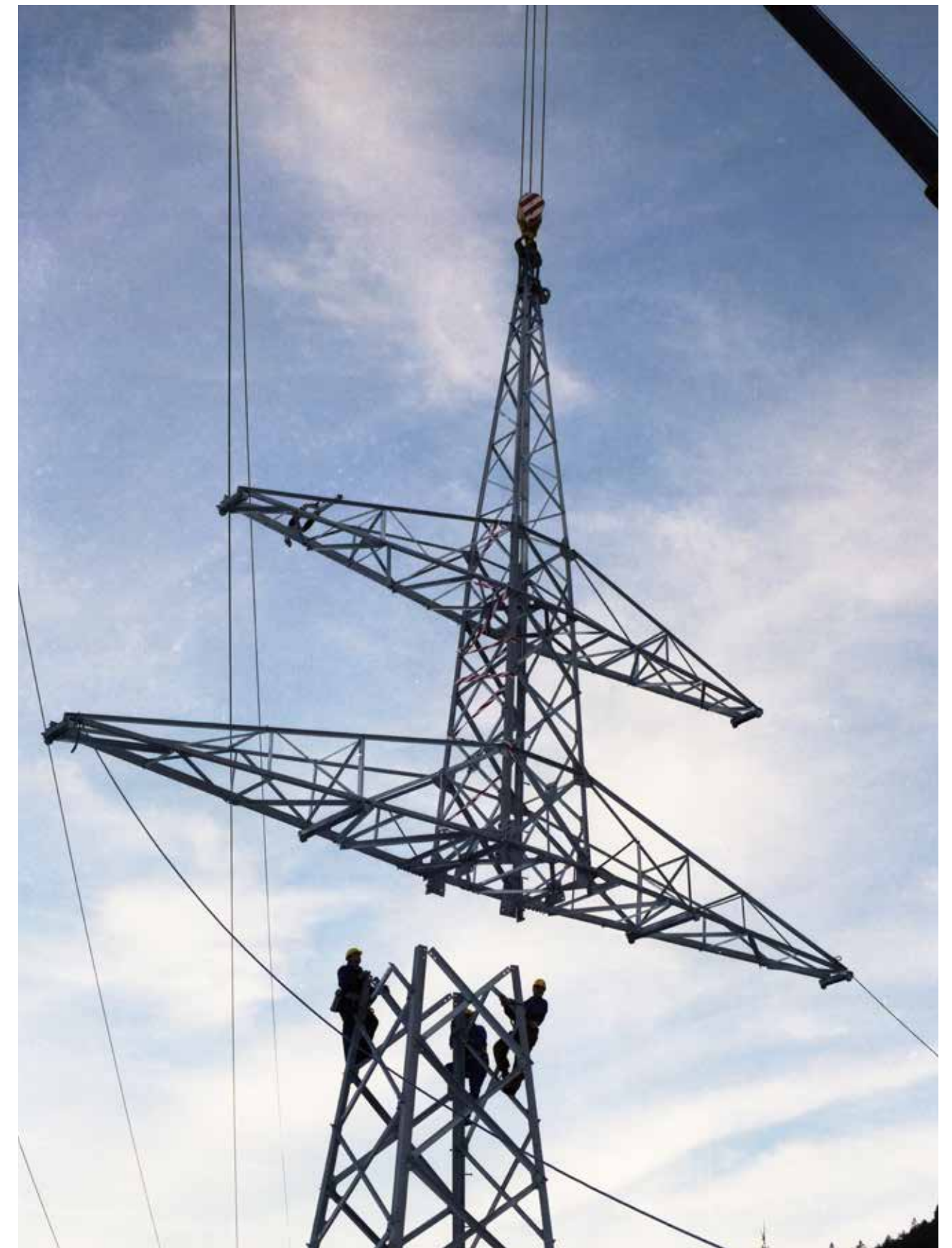
Seit rund zehn Jahren verfolgt die TINETZ ein umfassendes Ausbauprogramm in Osttirol. 63 Projekte in 23 Gemeinden konnten erfolgreich umgesetzt werden.
