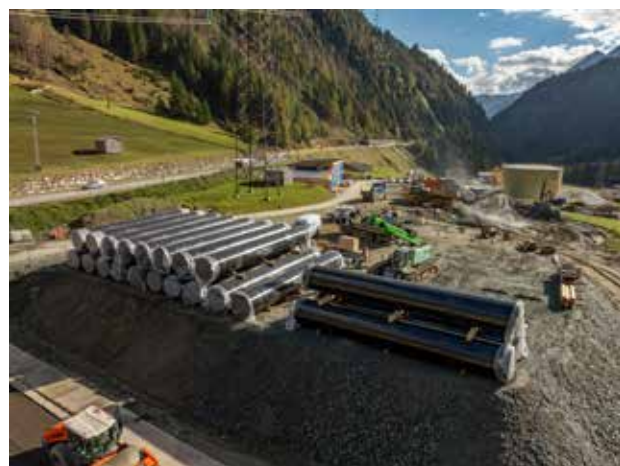
Die Rohre für die Druckrohrleitung warten hier noch auf ihren Einbau. Sie haben einen Durchmesser von 1,8 Meter und eine Länge von 13,5 Meter.
