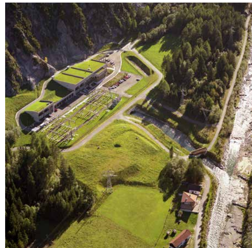
Unscheinbar fügt sich das Draukraftwerk Amlach aus der Vogelperspektive in die Umgebung ein.
