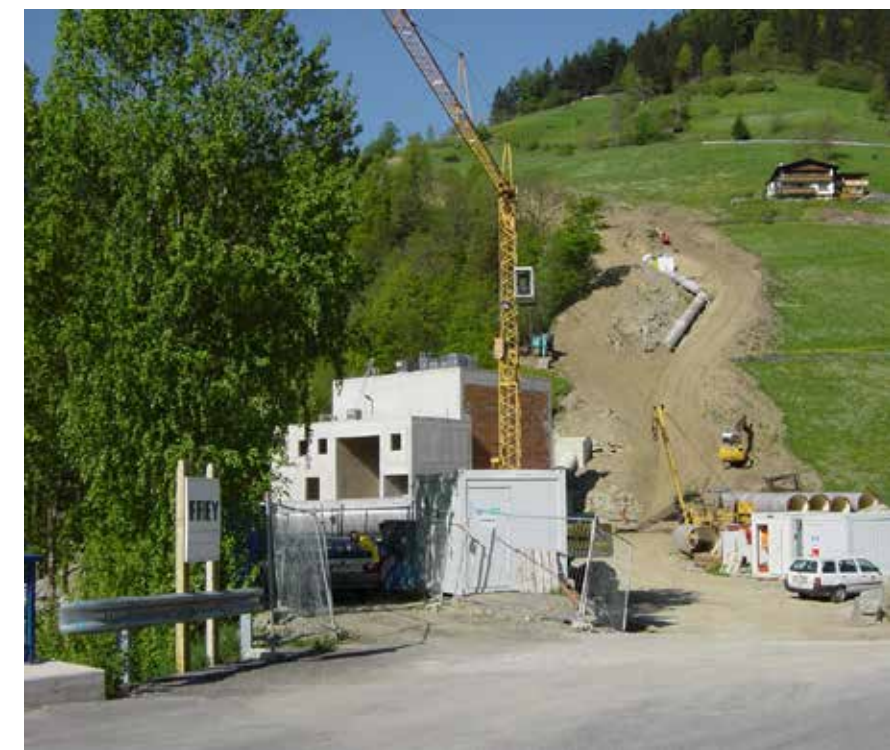
Bau des 2007 eröffneten Laufkraftwerkes Schwarzach zwischen Hopfgarten i. D. und Huben.
