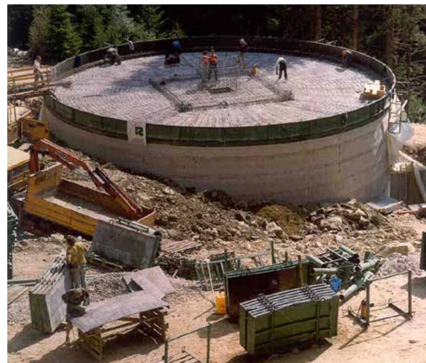
Kleinwasserkraftwerk Leibnitzbach: Errichtung des Speichertopfes 1992.
