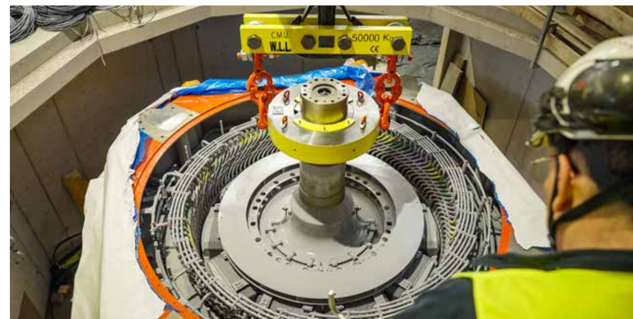
Einhub des 46 Tonnen schweren Rotors in den 23 Tonnen schweren Stator.
