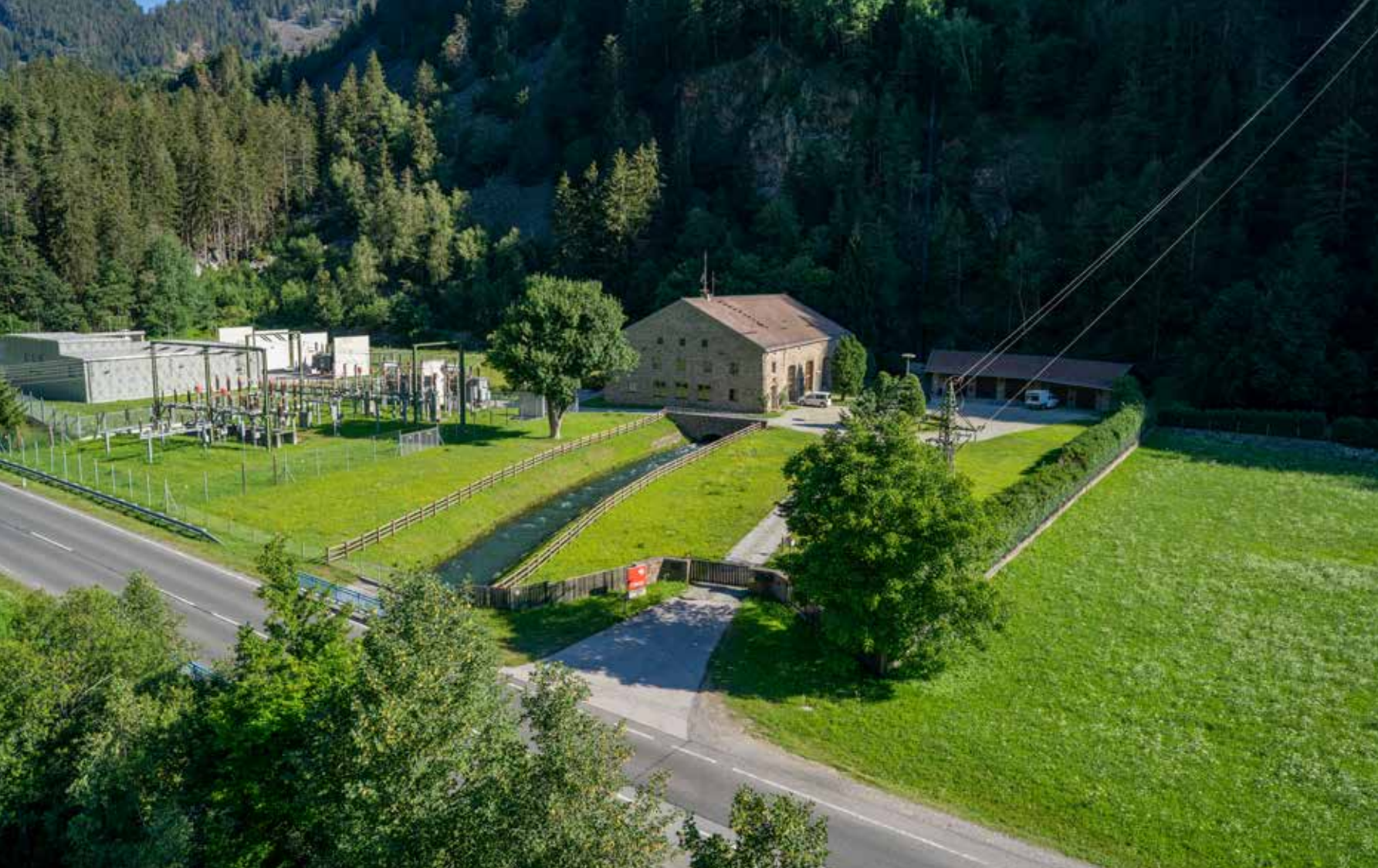
Das Kraftwerk Kalserbach besticht durch seine besondere Architektur und zählt seit seiner Inbetriebnahme 1950 noch immer zu den größten Anlagen Osttirols.
