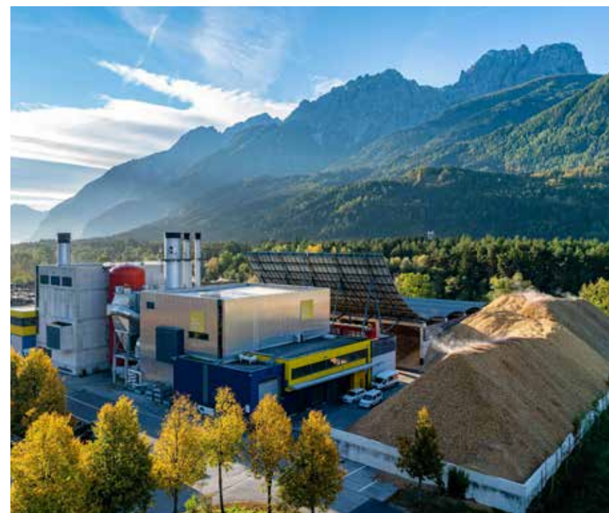
Das Biomasseheizkraftwerk in Lienz versorgt seit seiner Erweiterung im Jahr 2005 rund 10.000 Einwohnerinnen und Einwohner der Bezirkshauptstadt und der Nachbargemeinde Nußdorf-Debant mit nachhaltiger Wärme.
