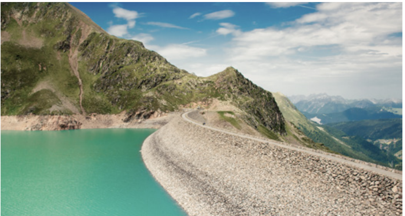
Speicher Finstertal – Blick auf die Dammkrone
