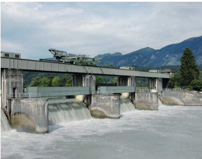
Wehranlage und Wehrfelder
