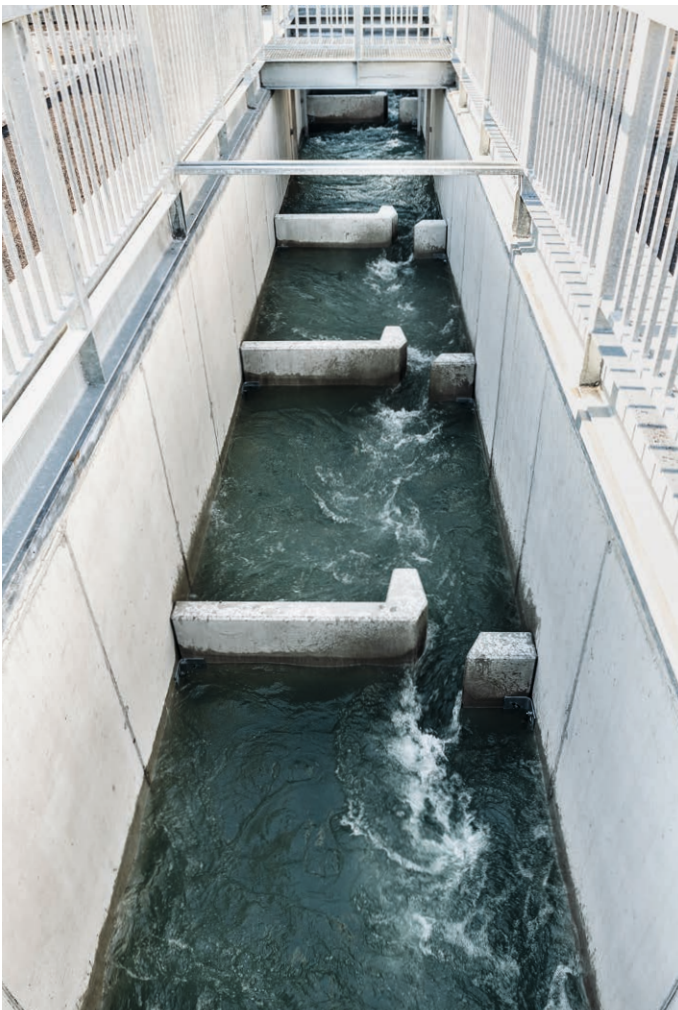
Die Fischwanderhilfe ermöglicht das Auf- und Abwärtswandern von Fischen an der Wehranlage.
