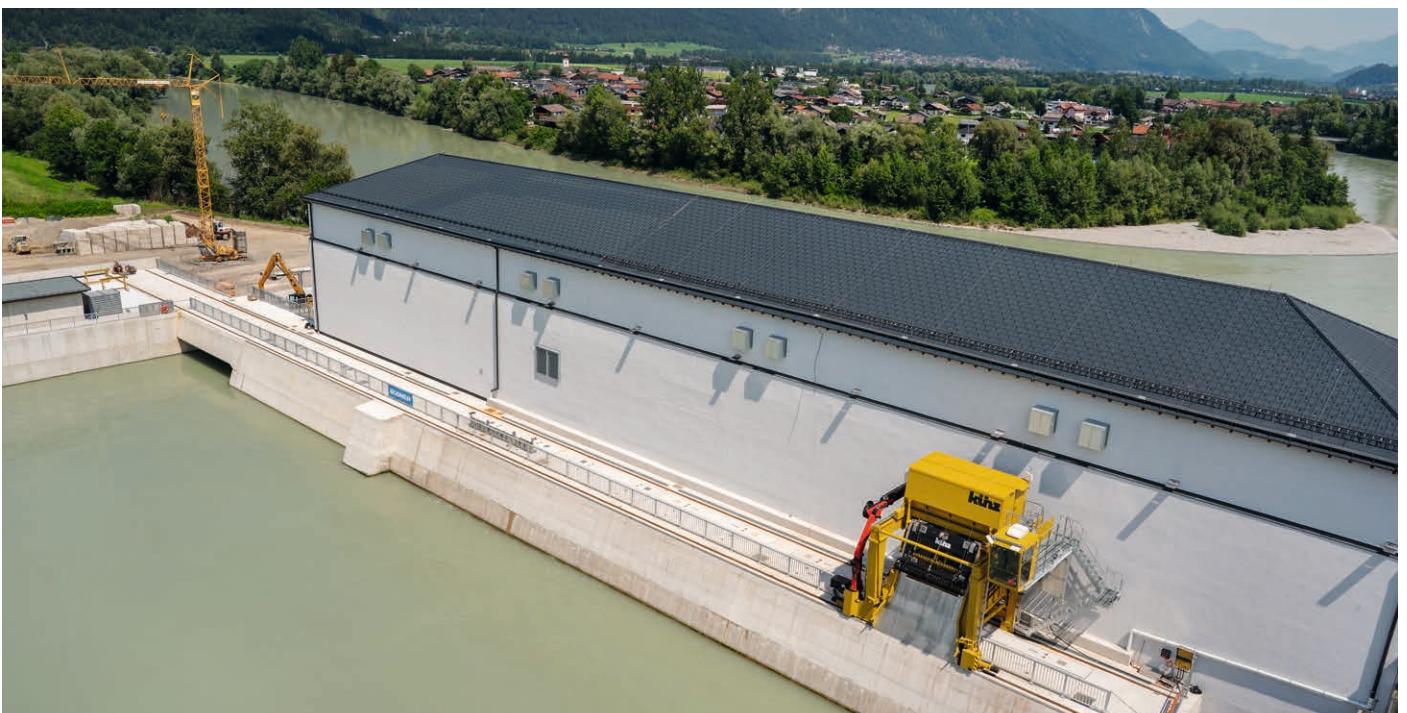
Eine fahrbare Rechenreinigungsmaschine entfernt Treibgut aus dem Oberlauf des Inn und trägt damit maßgeblich zum Gewässerschutz bei.
