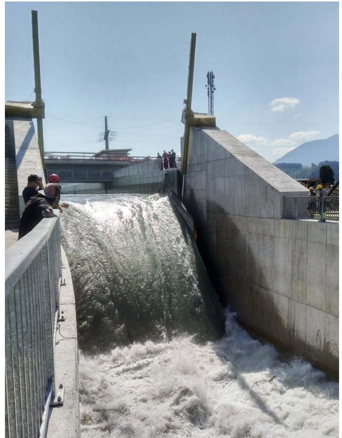
Das fünfte Wehrfeld kann bei Hochwasser rasch bedient werden, um die Wehranlage zu entlasten.
