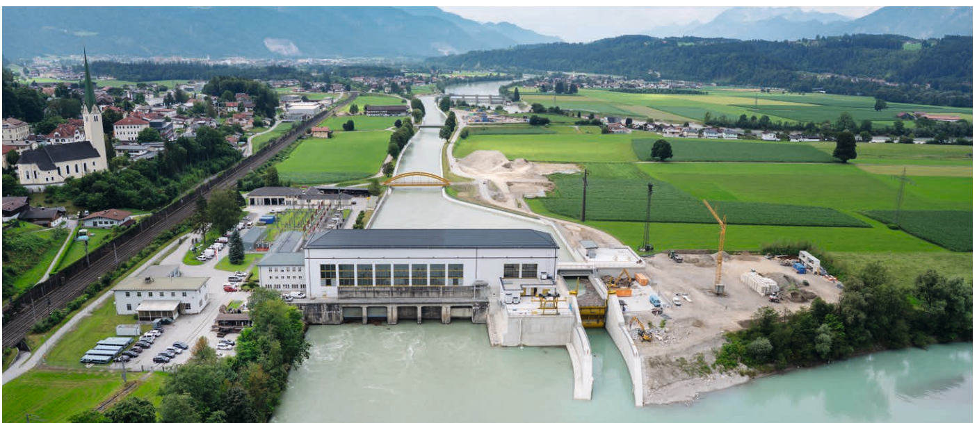
Baustelle am Krafthaus in Blickrichtung Westen
