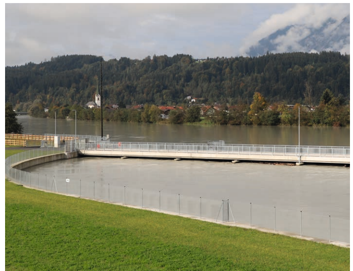
Einlaufbauwerk mit Brücke
