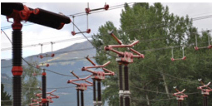
220 kV-Leistungsschalter
