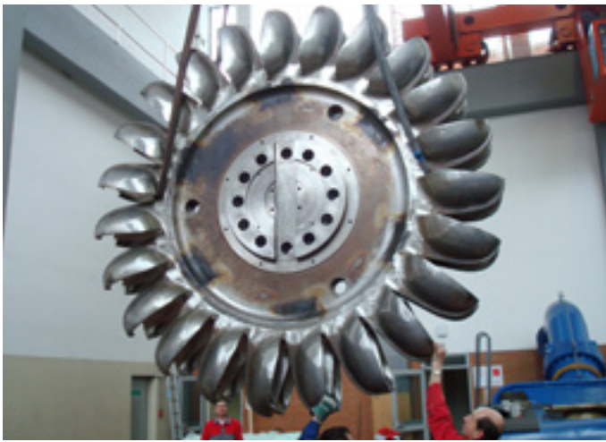
Einbau eines Turbinenlaufrades
