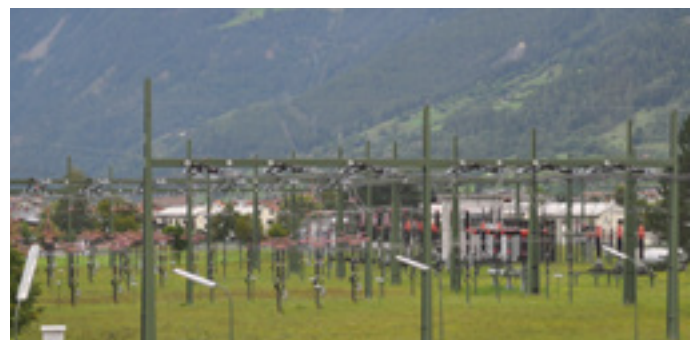
220 kV-Scherentrenner
