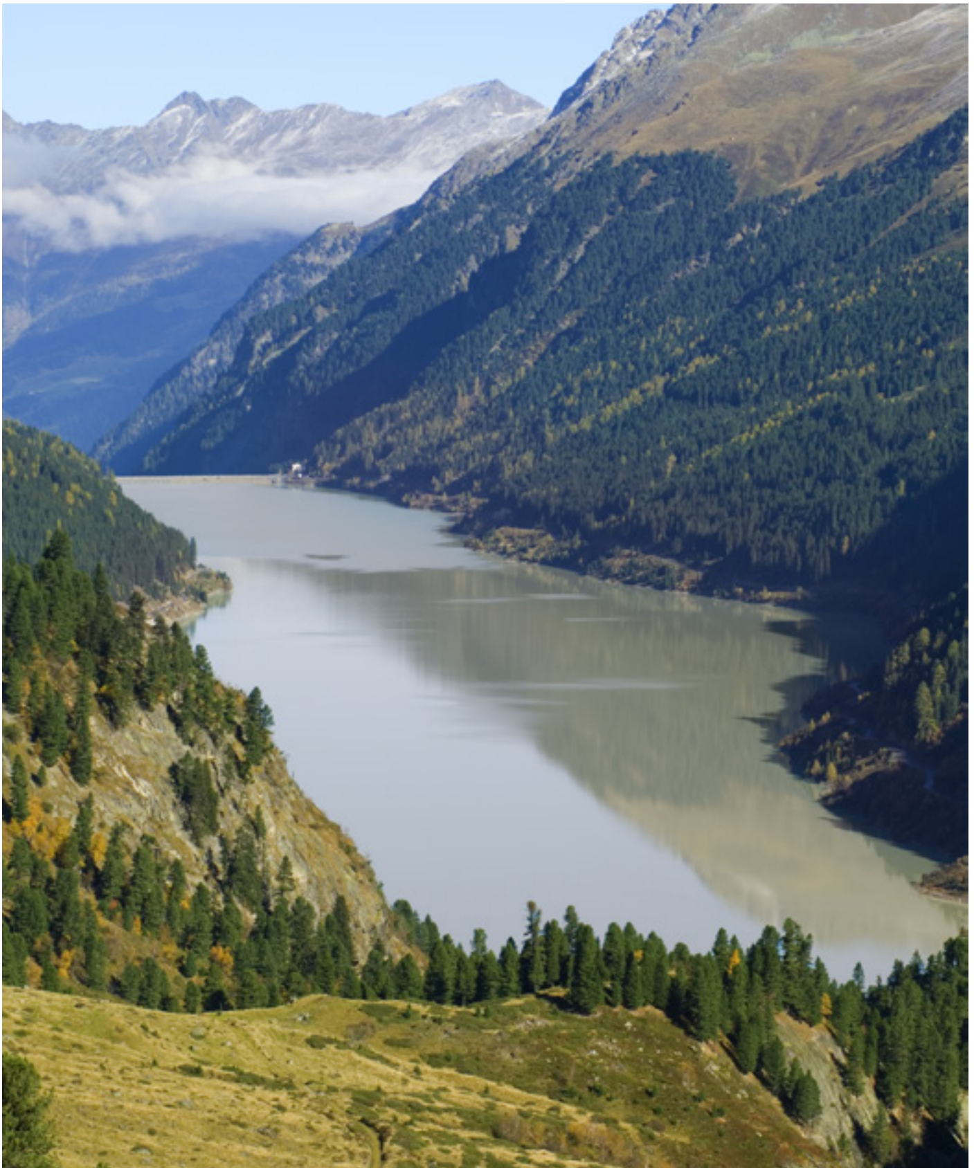
Blick auf den Speicher Gepatsch und den 153 m hohen Steinschüttdamm im Kaunertal.
