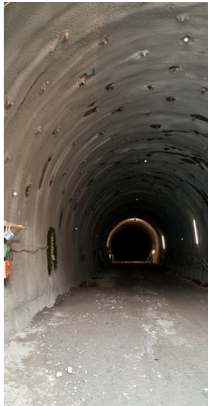
Stollen für den neuen Kraftabstieg (2016)
