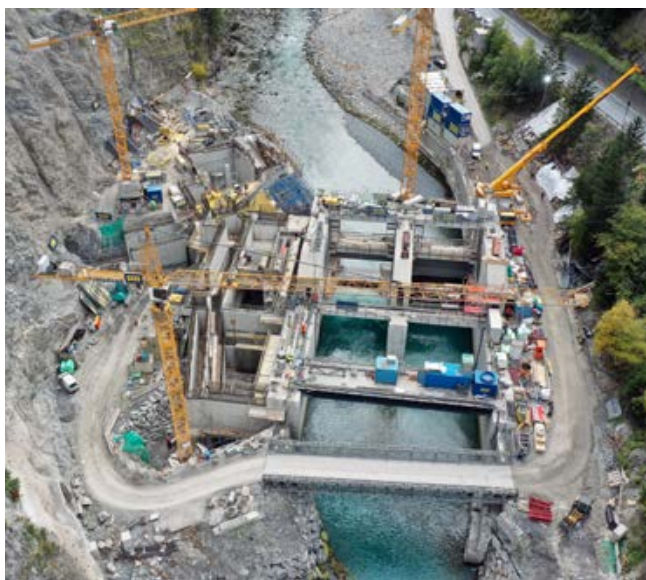
Arbeitsfortschritt am Einlaufbauwerk an der Grenze zur Schweiz. Diese aufwändige Baumaßnahme dient zugunsten der ökologischen Verbesserung des Inn im Wesentlichen der Dämpfung von Schwall-Sunk-Effekten, die durch die Oberlieger-Kraftwerke verursacht werden.
