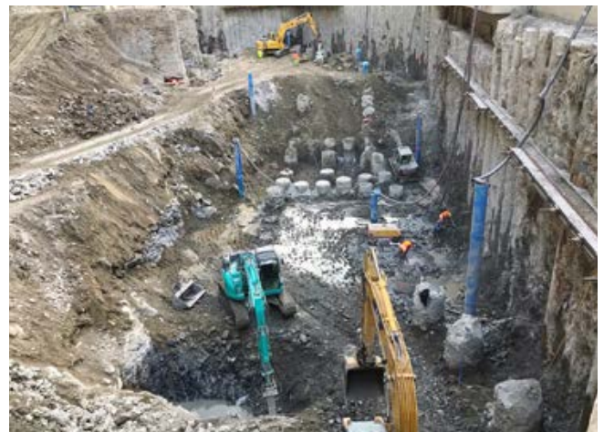
Aushub der Baugrube am Dotierkraftwerk
